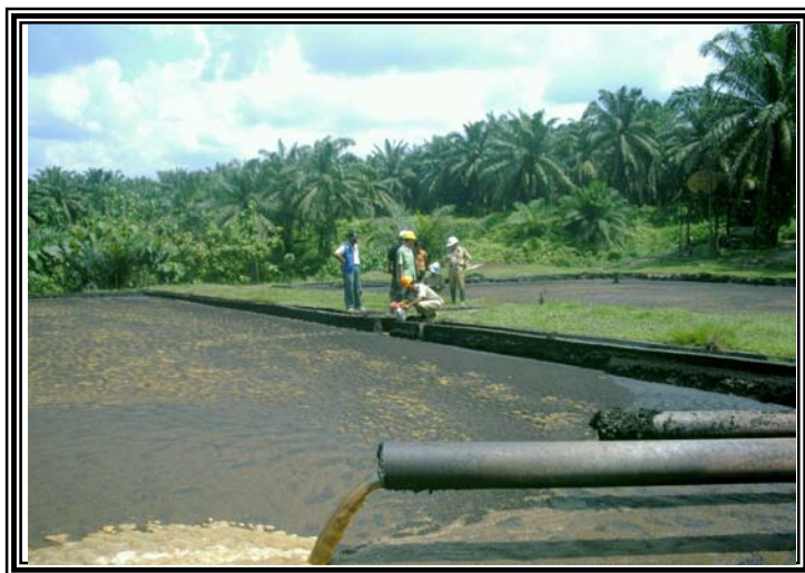
Gambar : Kolam Limbah Cair dari Pabrik Kelapa Sawit, yang harus dilakukan pemantauan dan pengelolaan secara rutin dan continue.
