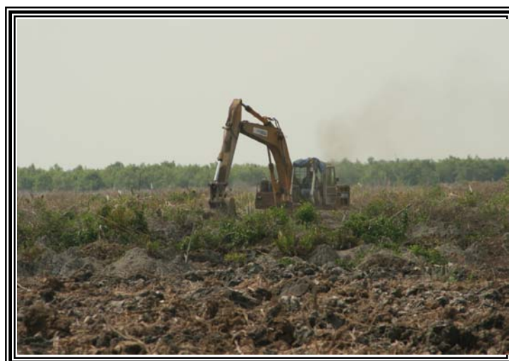
Gambar : Pengrusakan dan Pembabatan Hutan Mangrove dilakukan dengan menggunakan alat berat untuk membuka areal Perkebunan Kelapa Sawit di Desa Lubuk Damar Kecamatan Seruway
